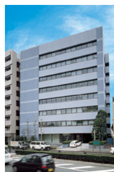
III-3 JEI本郷ビル ■ JEI Hongo Building
